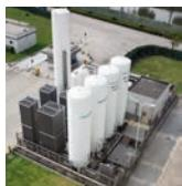
**Генераторы PRISM® для производства кислорода, азота или водорода на объекте**, созданные по последнему слову техники, реализуются в разных формах — от комплектных мембранных систем до криогенных установок — производят газ чистотой от 95% до 99,9995%, вне зависимости от требуемой производительности, обеспечат надежную и экономичную поставку газа.
